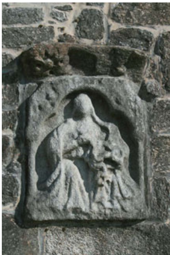
Detalle de la fachada de Santa María de la Atalaya.
